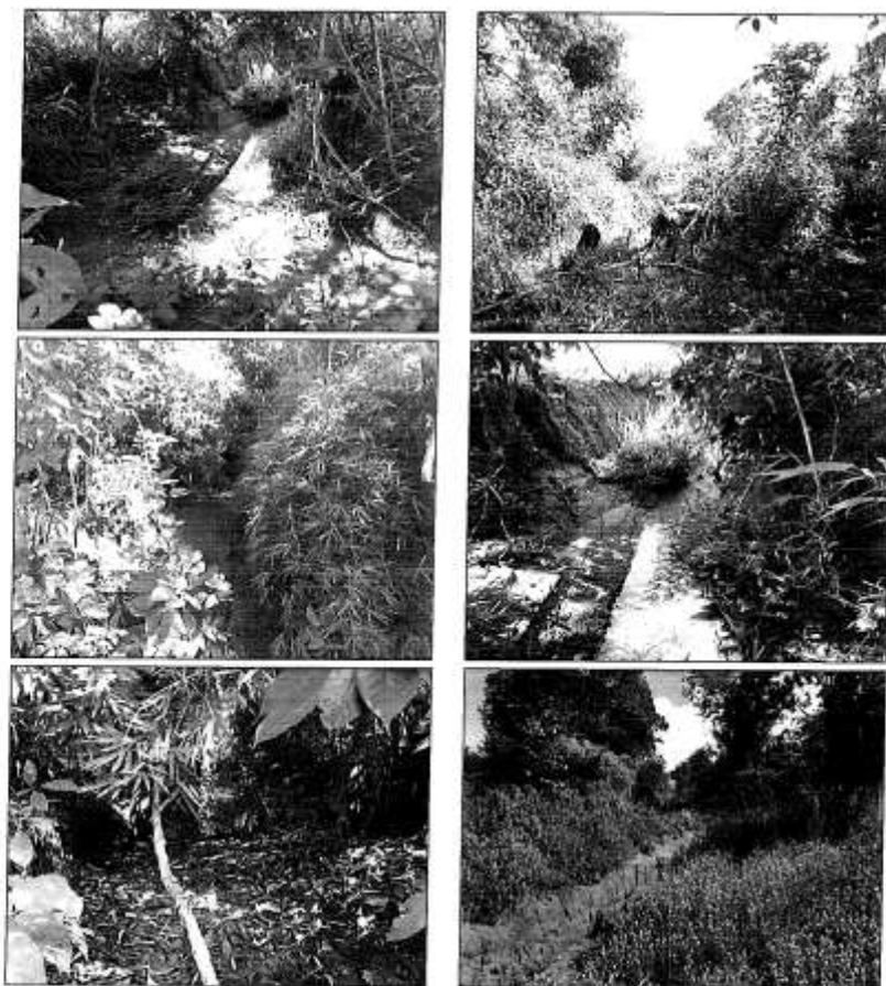
Foto 01 – Local de execução do bueiro.
