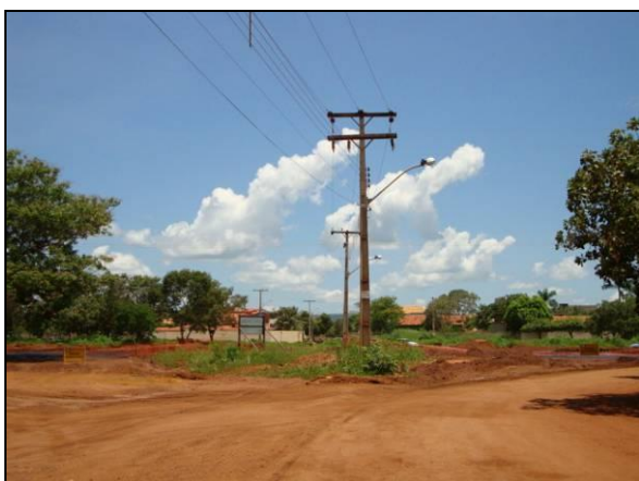
Foto 21. Vista parcial do local de implantação de canteiro central na quadra.
