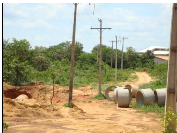
Foto 22. Vista parcial de local destinado a canteiro central na quadra.
