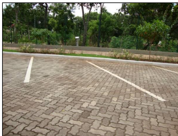
Foto 2. Vista parcial de pavimento permeável executado no município.
