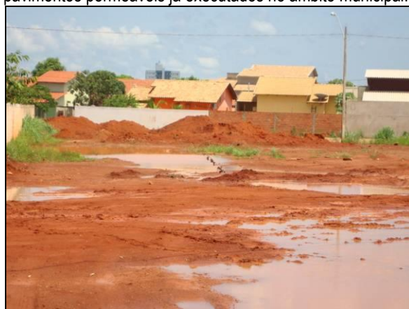
Foto 10. Vista parcial do local de execução de passagem de pedestre.
