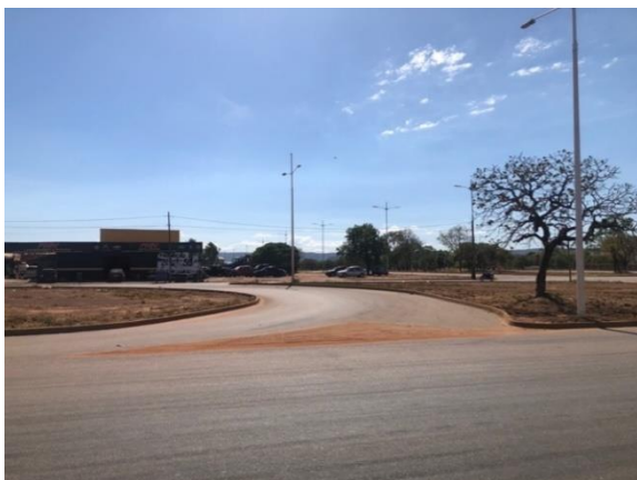
Figura 11 - Ponto AP04 – ausência de sinalização
