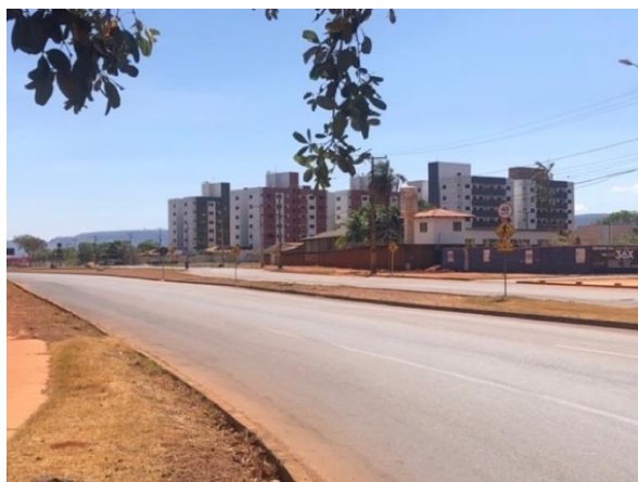
Figura 17 - Distribuição da sinalização vertical
