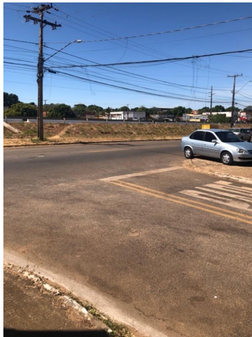
Figura 16 - Ponto B04 – Ausência de redutores de velocidade
