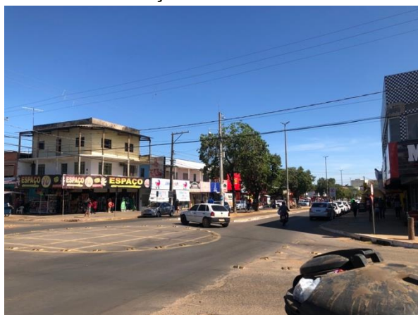
Figura 21 - Faixa área de conflito para indicação com tachões
