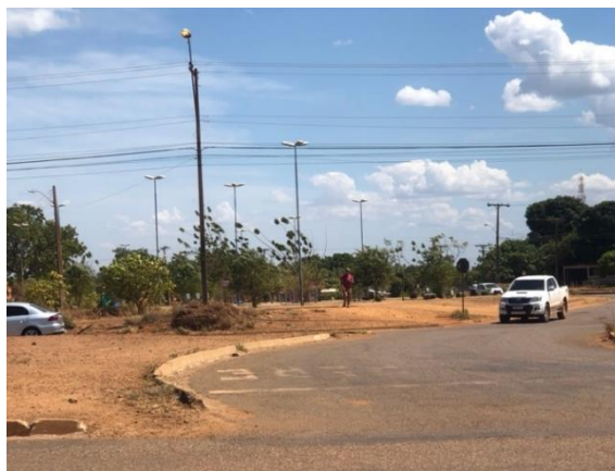
Figura 12 - Ponto AP07 – sinalização desbotada
