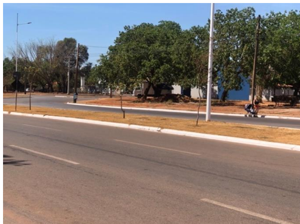
Figura 27 - Percurso sem calçadas
